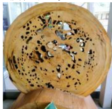
室生寺のレンコン腐れの衝立
