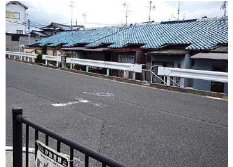
古川は堤防が高く天井川になっている
