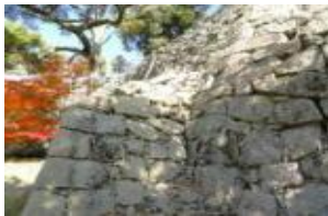
姫路城の石垣補強
